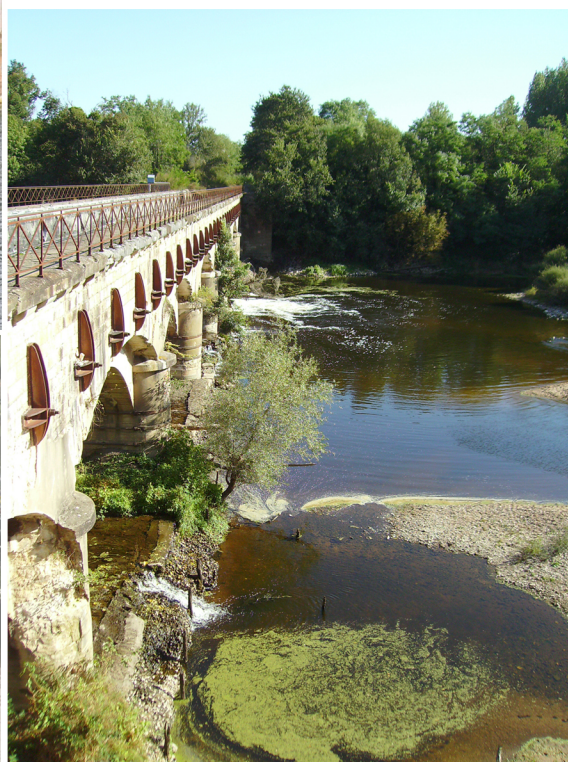
Pont-canal de la Tranchasse (canal de Berry) sur le Cher
